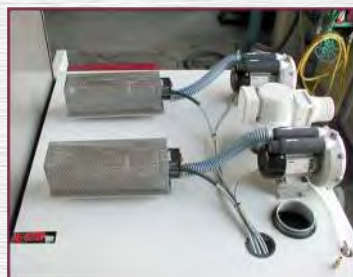
(Option) Heißlufttrocknung mittels Hochleistungsgebläse
