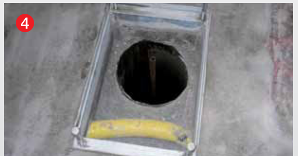
4 Bereit für die Montage der neuen Hebebühne
