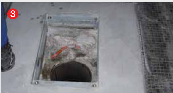
3 Der neue Einbaurahmen wird in den Boden versetzt und das Aussenrohr gekürzt
