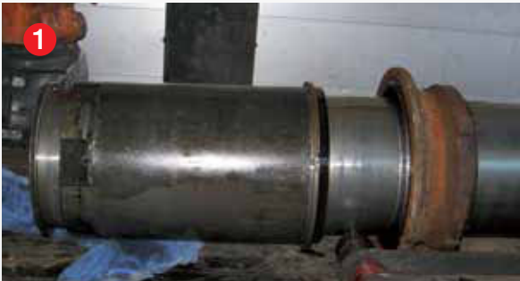
1 Kolben der alten 1-Säulenhebebühne wird demontiert
