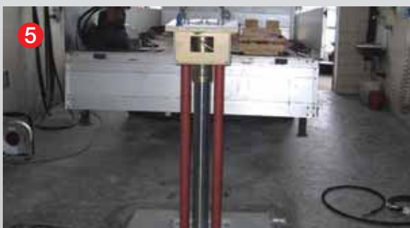
5 Die neue Hebebühne wird montiert
