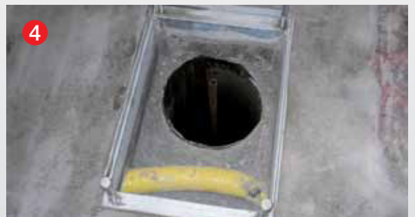
4 Bereit für die Montage der neuen Hebebühne
