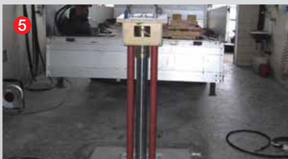
5 Die neue Hebebühne wird montiert
