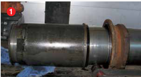
1 Kolben der alten 1-Säulenhebebühne wird demontiert
