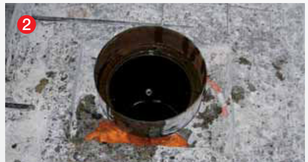
2 Das Aussenrohr der alten Hebebühne bleibt im Fundament
