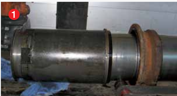
1 Kolben der alten 1-Säulenhebebühne wird demontiert
