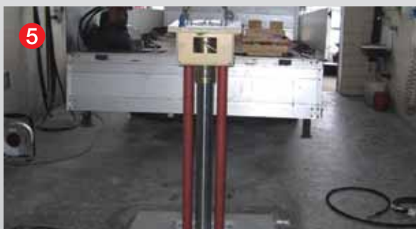
5 Die neue Hebebühne wird montiert
