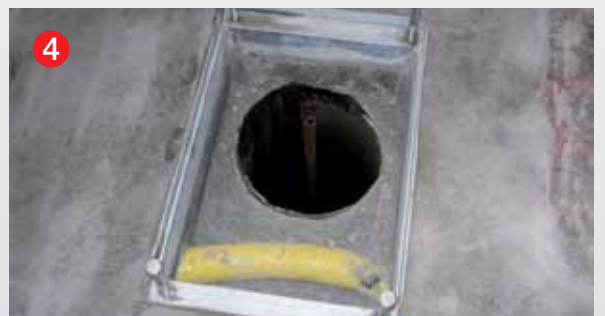
4 Bereit für die Montage der neuen Hebebühne
