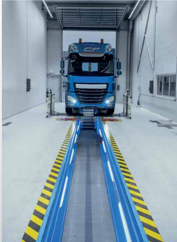
BALZER Fertigteilgrube in Füllkammerbauweise. Alle Anschlüsse gemäss Planung für Elektro, Druckluft, Abluft, Ölversorgung und Entsorgung. Grubenwasserentsorgung wahlweise über Gully oder Pumpensumpf. Doppelgrubenrahmen mit Installationsmöglichkeit für Schiebeabdeckung, Heber, Ölwanne, Abstützbrücken etc.
