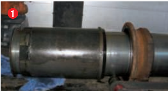
1 Kolben der alten 1-Säulenhebebühne wird demontiert
