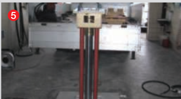
5 Die neue Hebebühne wird montiert
