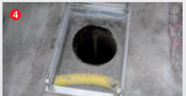
4 Bereit für die Montage der neuen Hebebühne
